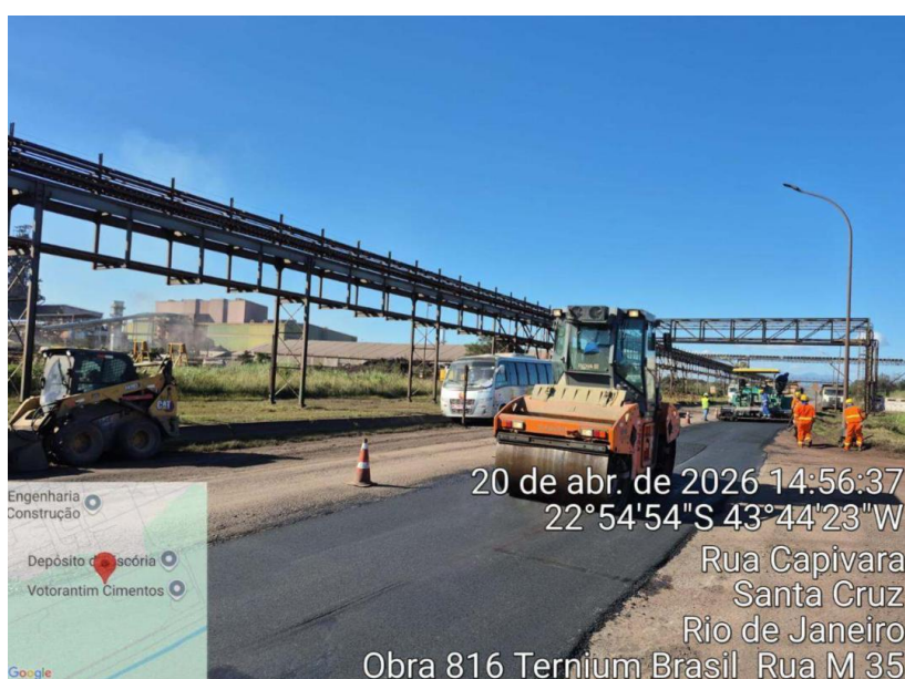
(manutenção de pavimentos – Santa Cruz)
